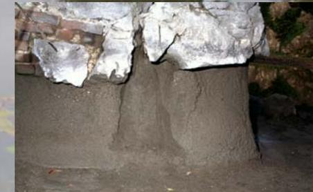
1991 Einsturzgefährdete Felsen - Fundamentaushub - Eichenpfahlgründung - Sandstrahlung der Klinkerhintermauerung und Spritzbetonversiegelung
